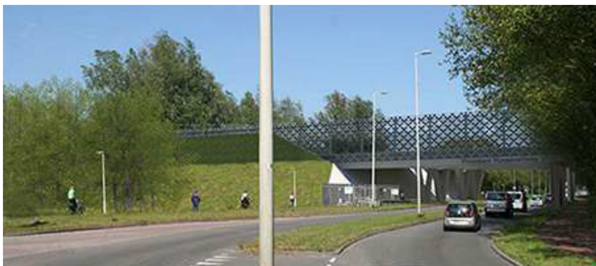
A13 Het nieuwe viaduct over de President Rooseveltweg met geluidsschermen.
