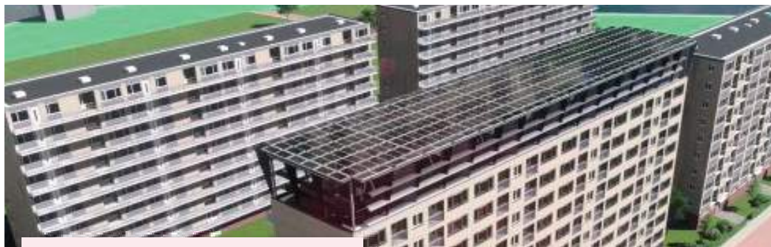
Gevelisolatie in combinatie met zonnepanelen
